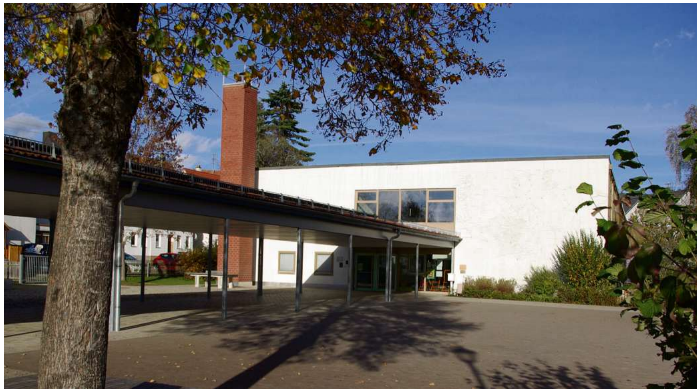
Die Heizung in der Grundschule wird umgestellt, die Steuerung optimiert – und die Kosten steigen nach oben.
